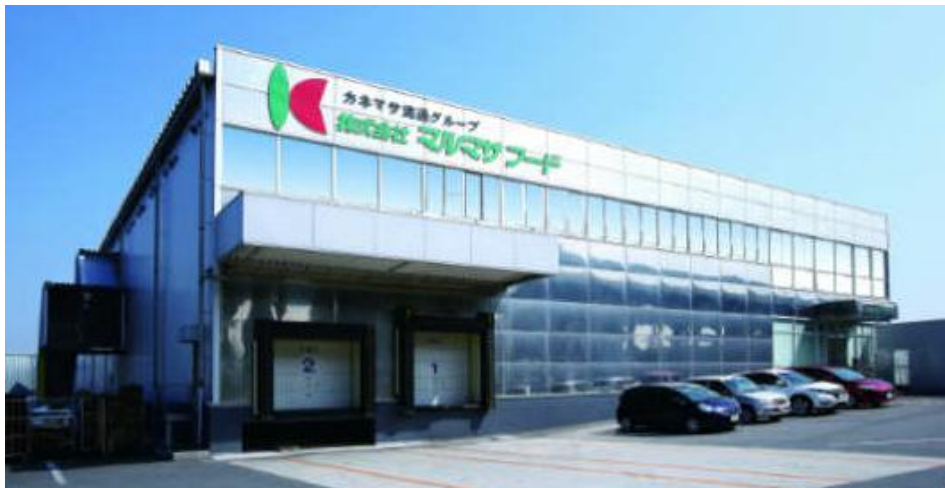
写真② 同社堺工場外観（出典：同社グループ Web サイトより）
